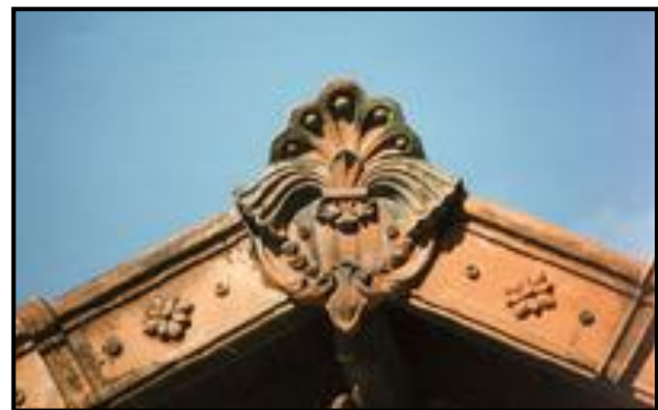
Pignon de toit avec fronton et tuiles de rives
