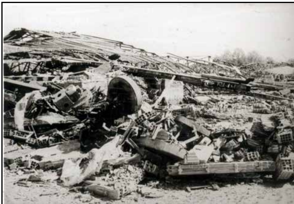
Démolition du dernier bâtiment de l'usine Simonnet
