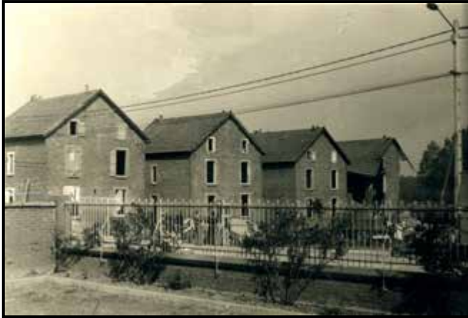
Commencement de la démolition des cités de la coopérative.
