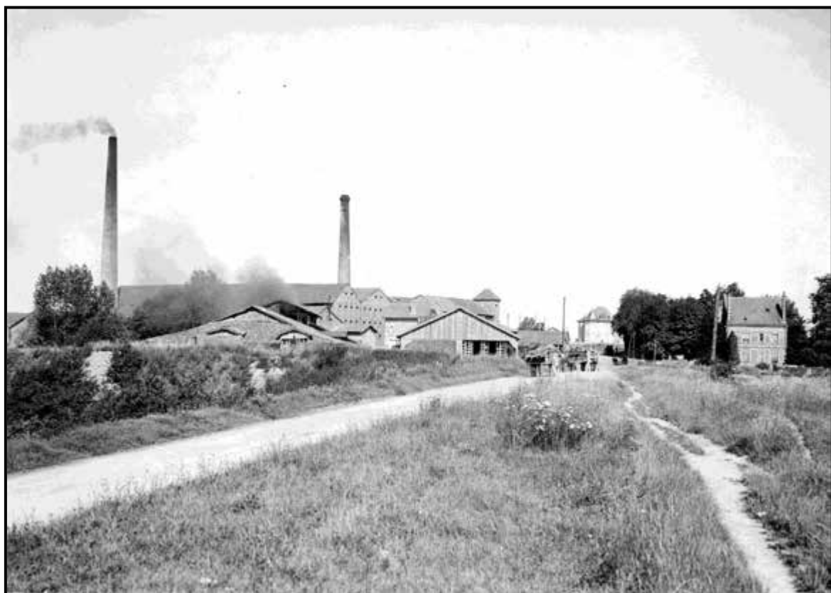
Ancienne usine Huguenot, route de Maurupt
