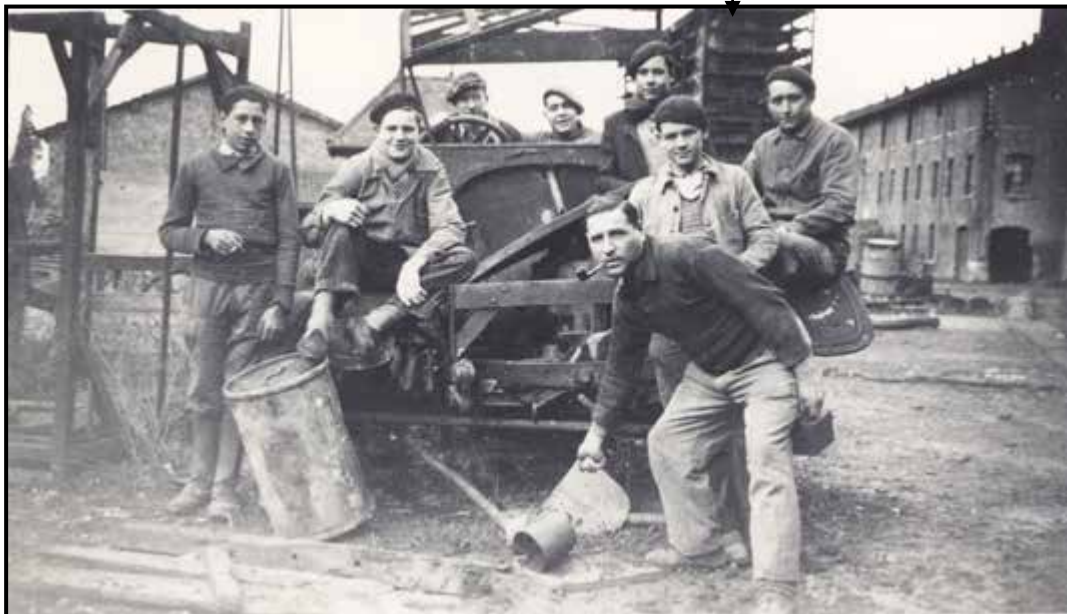
Derrière les ouvriers, on voit le réfrigérant qui servait à refroidir l'eau des chaudières
