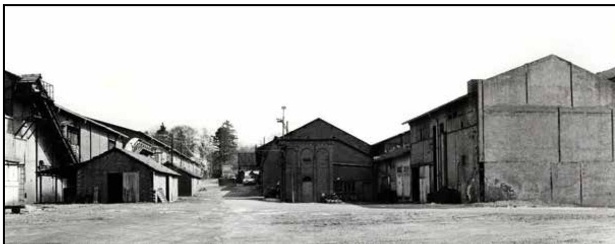
Vue partielle de la tuilerie Gilardoni
