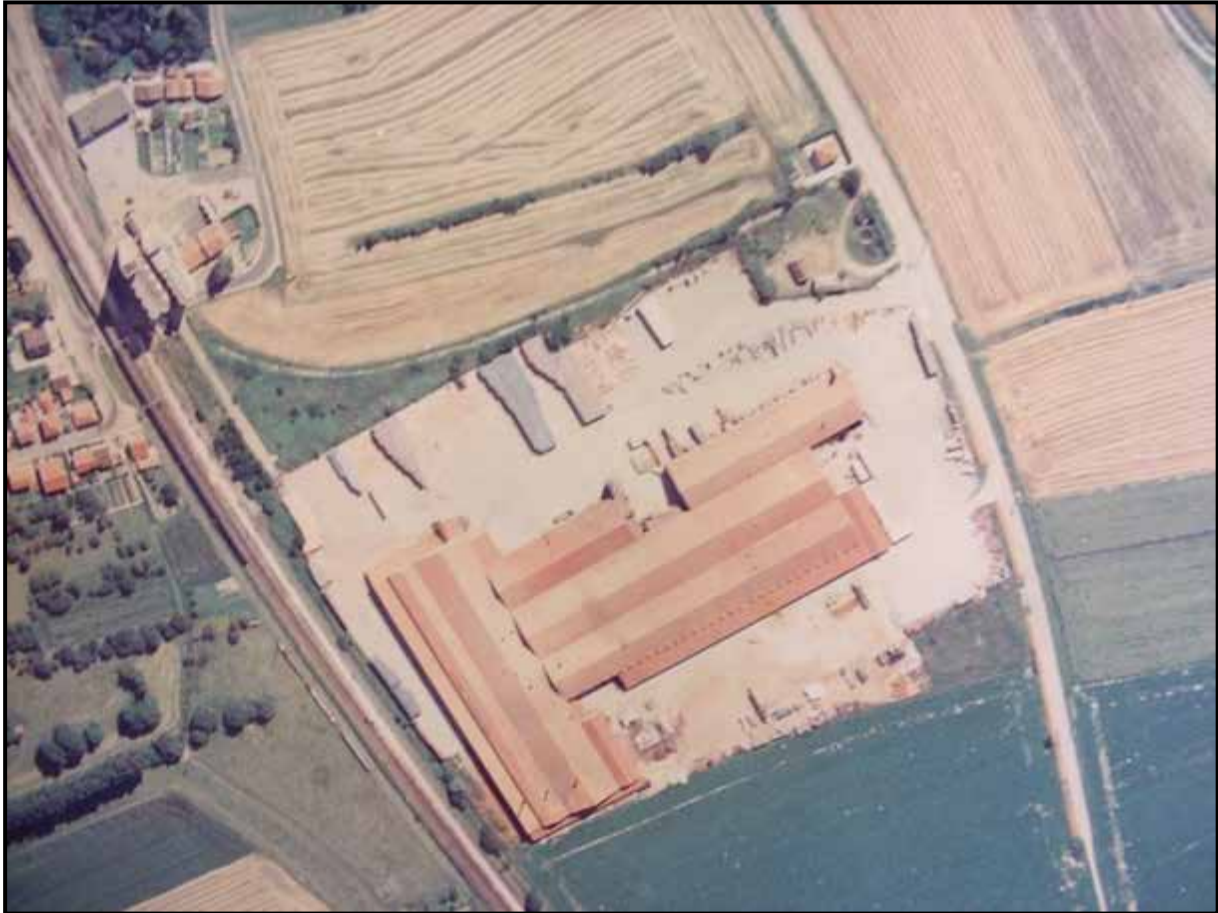
Vue aérienne de la tuilerie en 1990
